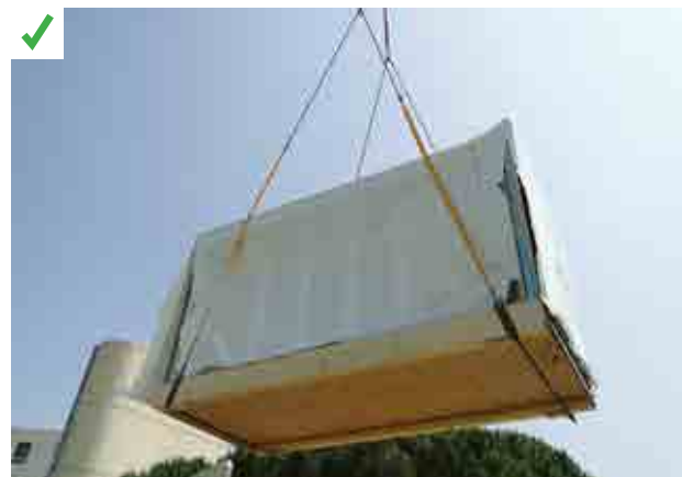
Levage par le bas d'un module 3D. ©AQC
