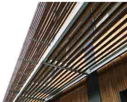
Exemple d'une solution corrective : installation de protections solaires pour limiter les apports solaires. ©AQC
