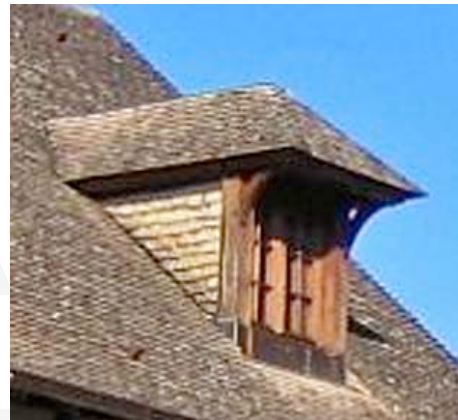
Lucarne à la capucine de la région de Troyes sur laquelle on remarque l'habillage en bardeaux de bois des jouées, ainsi qu'une belle enrayure à encorbellement.
