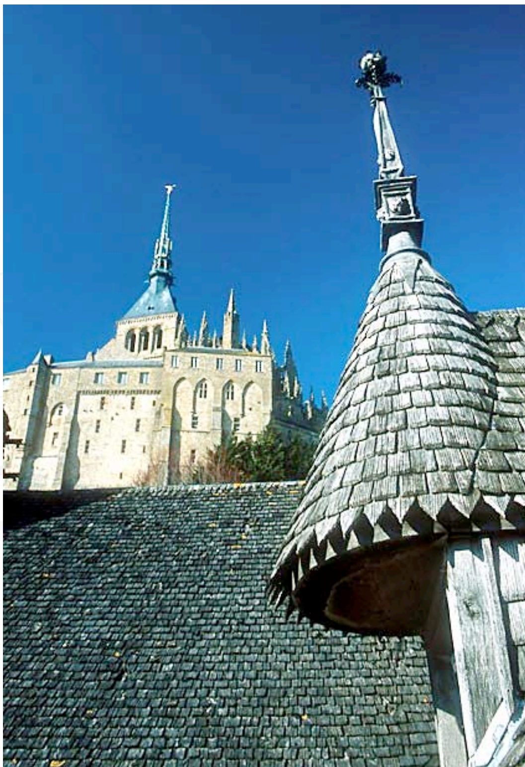
Lucarne à tourelle à proximité du Mont-Saint-Michel (50), couverte en bardeau de châtaignier.
