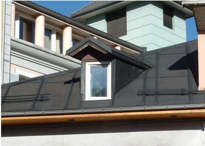
Lucarne couverte en zinc prépatiné, à l'extrémité d'un arêtier, à Albertville (73)
