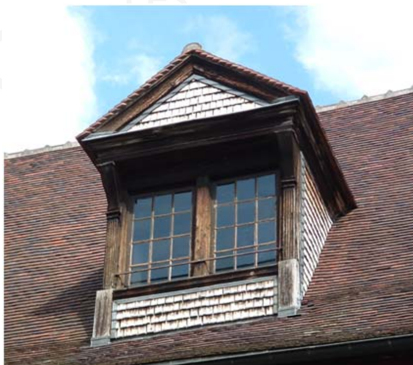
Lucarnes de La Maison de l'Outil et de la Pensé Ouvrière à Troyes (10), couvertes en tuiles et habillées de Châtaignier.
