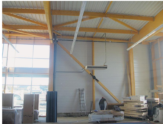
Figure 5.21 Un troisième point d'appui est créé par les butons (© Charpente Fournier).
