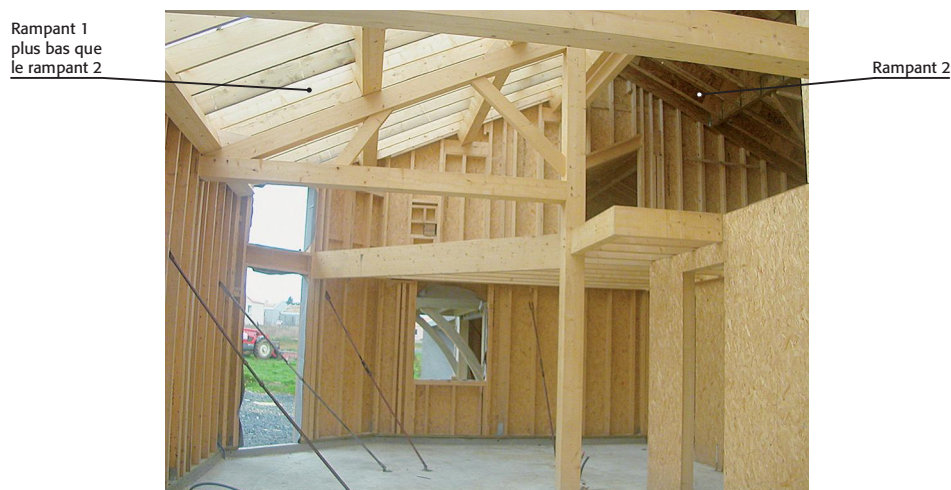
Figure 5.9 L'épaisseur de cette panne permet de reprendre les efforts de rampant en limitant sa déformation, car les deux rampants sont à une hauteur différente (© Groupe Leduc).
