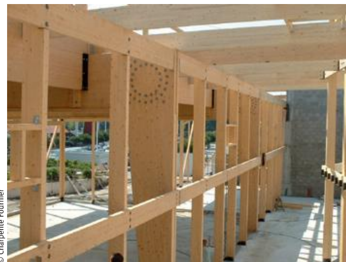
Figure 7.175. La barre horizontale au milieu des poteaux divise par deux la longueur de flambement, renforce la faible inertie et transmet les efforts d'antiflambement sur la maçonnerie.
