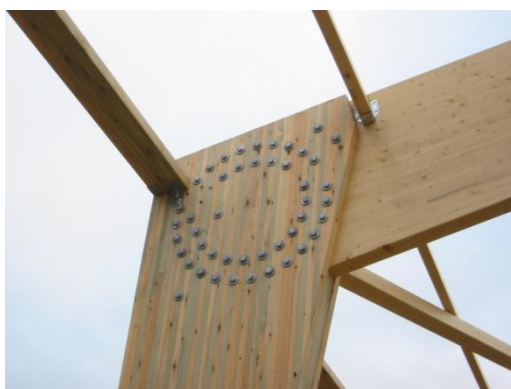
Figure B35 : Assemblage avec couronne de boulons modélisé en liaison encastrement (@ Charpentes Fournier)
