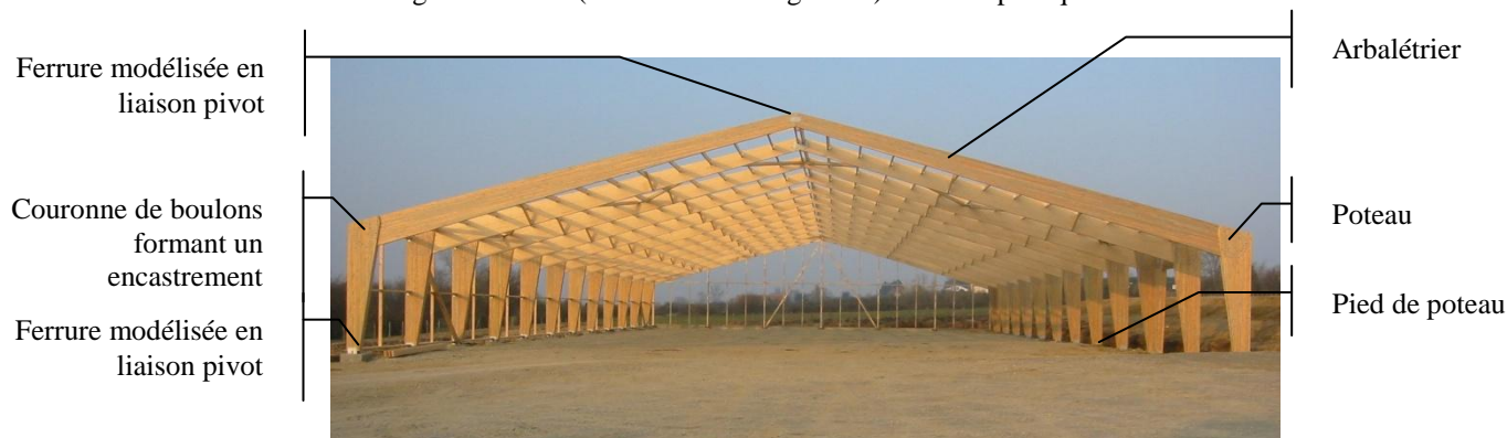
Figure B33 : Portique à trois articulations (@ Charpentes Fournier)
