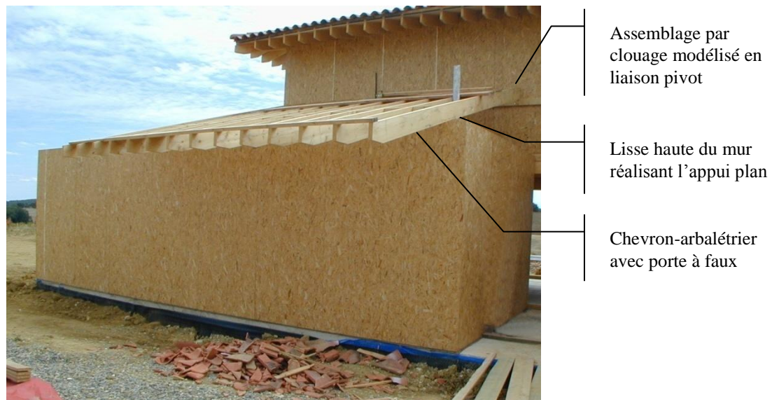
Figure B18 : Chevron-arbalétrier avec un porte à faux
