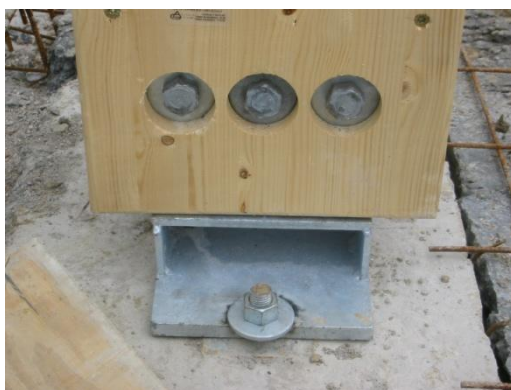
Figure B34 : Assemblage de pied de poteau avec une ferrure modélisée en liaison pivot (@ Charpentes Fournier)
