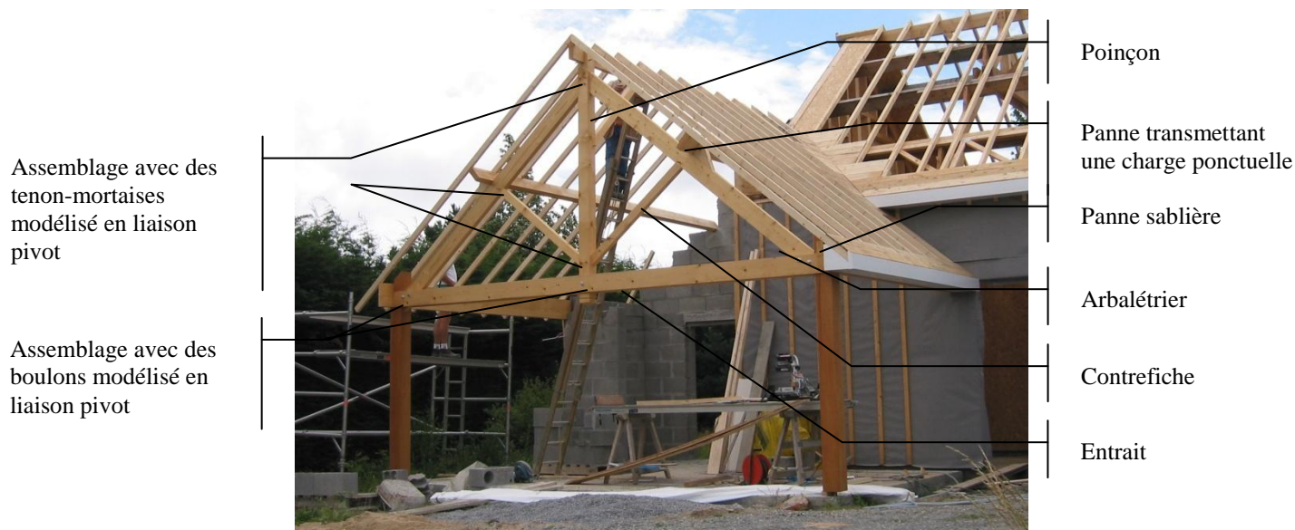
Figure B22 : Chevron-arbalétrier avec un porte à faux (@ Leduc Structure Bois)
