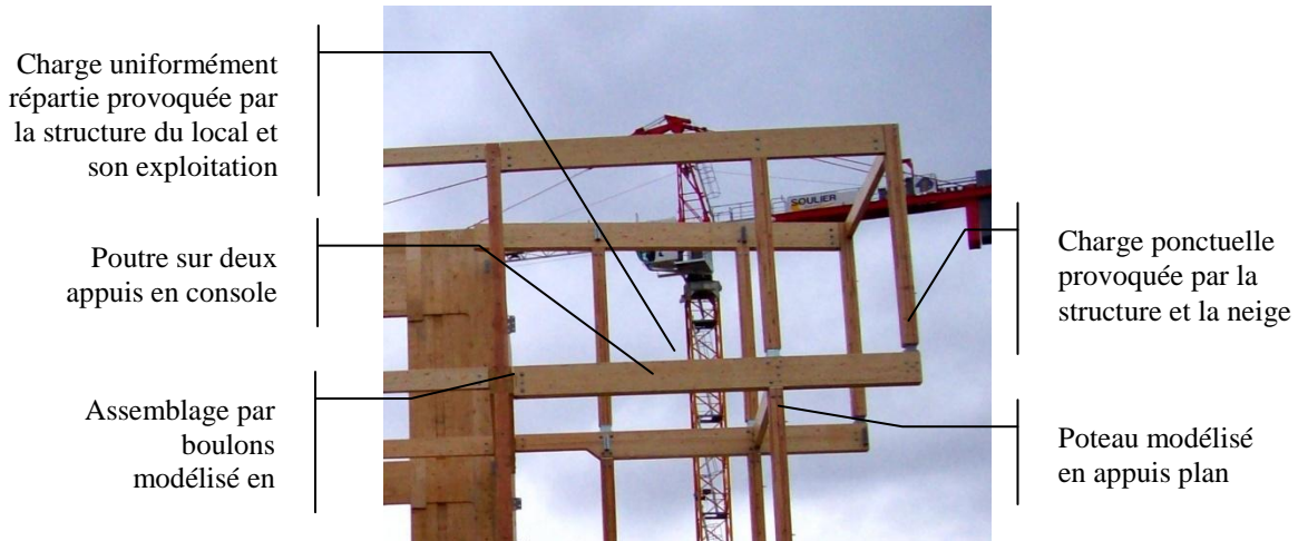
Figure B15 : Poutre sur deux appuis en console avec une charge ponctuelle
