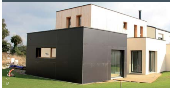
Vêtue mixte : enduit, acier et bardage bois
