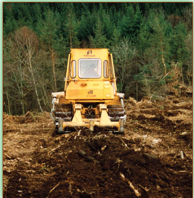
Sous-solage - DRAAF Auvergne
