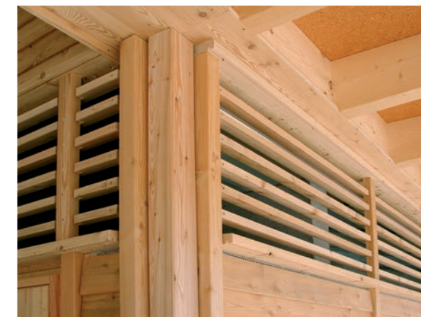
▼ Les façades en mélèze se composent de panneaux préfabriqués en ossature bois dont la partie supérieure est traitée à claire-voie.
