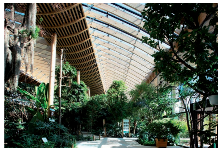
▲ A l'intérieur de la grande serre, les structures en lamellé-collé sont conçues pour laisser pénétrer un maximum de lumière naturelle tout en créant des zones ombragées.
