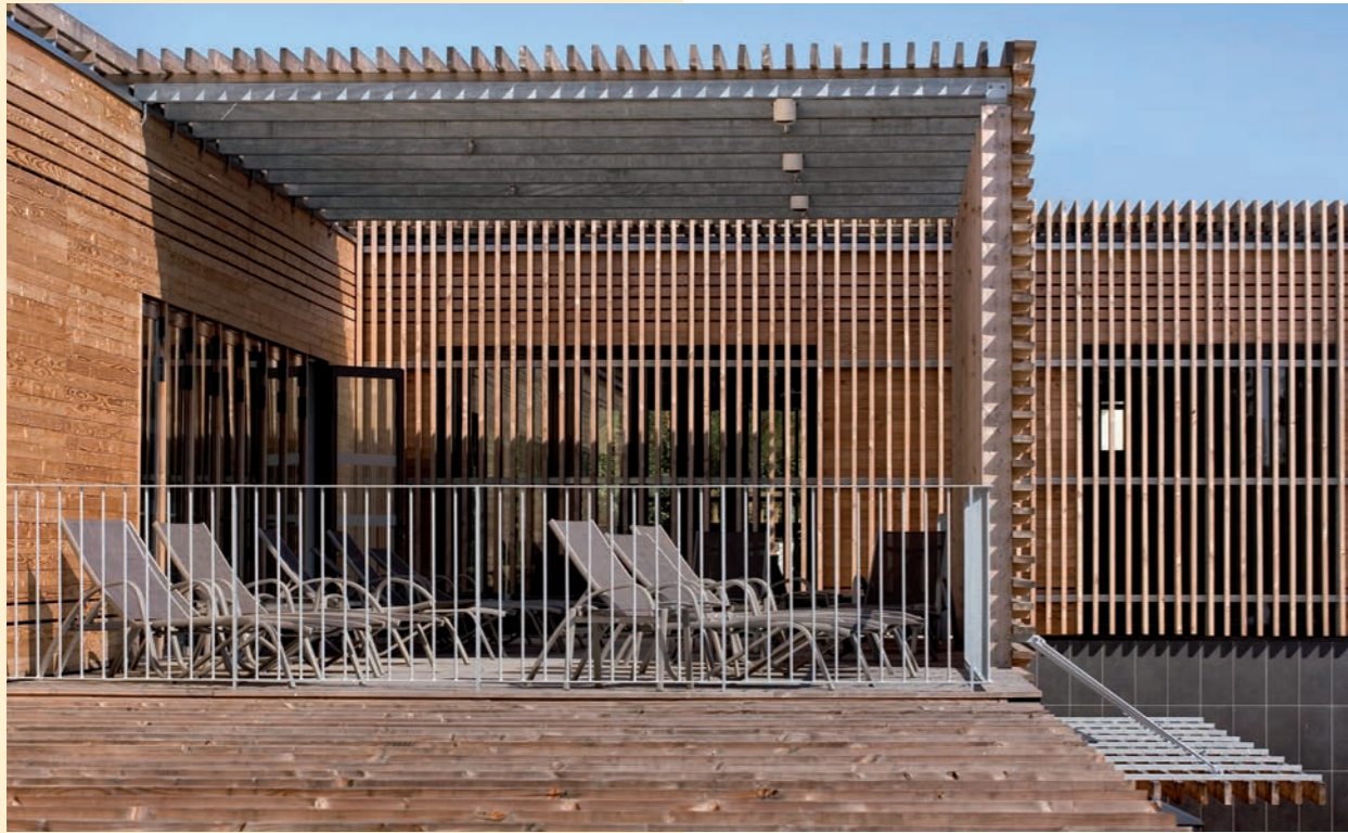
▲▼ Des ombrières en carrelats de Douglas protègent les terrasses de repos de la lumière vive méridionale.
