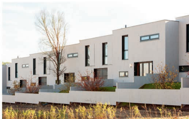
▲ Les logements sont décalés les uns par rapport aux autres pour compenser la déclivité du terrain.
