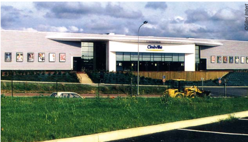
Maître d'ouvrage : Société des Films de l'Ouest Architecte : Gilles Imbert (44) Acousticien : Société Itac-Christian Bouyer
